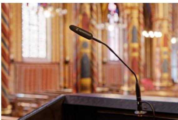
Sennheiser ME 36 an biegbaren MZH Schwanenhälsen sind an verschiedenen Positionen im Kirchenschiff installiert
